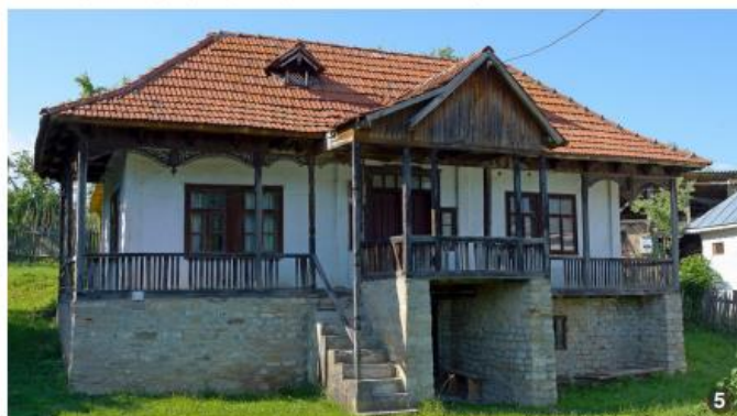
Acoperiș cu patru ape cu modelul de țigla cel mai des întâlnit.
