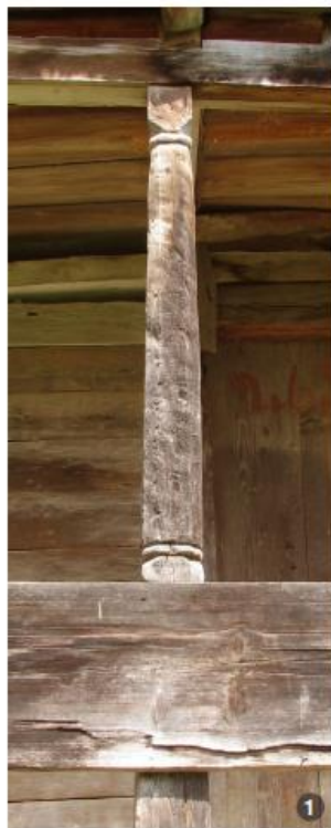
Stâlpii sculptați manual cu barda aparțin celor mai valoroase exemplare ale arhitecturii tradiționale.
