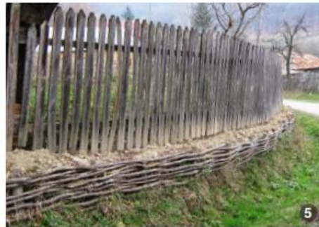
Zid de sprijin din împletitură de nuiele și împrejmuire din lemn.
