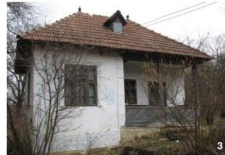
Elementele regulatoare care creează liniile principale ale fațadelor sunt determinate de linia de coamă, linia de streșină, prispa, temelie.
