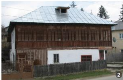
Elementele regulatoare care creează liniile principale ale fațadelor sunt determinate de linia de coamă, linia de streșină, prispa, temelie.
