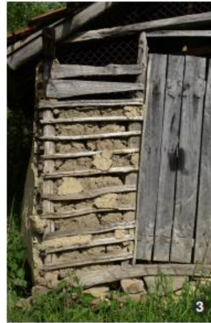
Detaliu schelet din pari de lemn înfiți în pământ cu șipci și umplutură de pământ.
