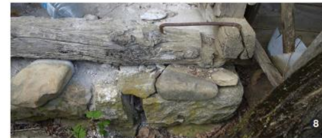
Fundație și soclu de piatră.
