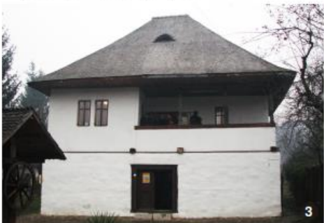
Construcție cu acoperiș în patru ape, cu învelitoare din șindriă.
