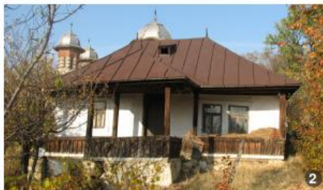
Acoperiș cu patru ape, cu învelitoare din tablă.
