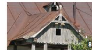
Foișorul poate avea trei sau două pante, poate avea fronton decorat sau nu cu traforuri abundente..
