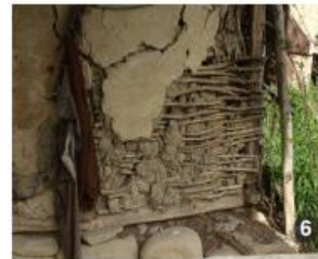
Detaliu de parament al unei case din lemn: tencuială din lut cu armătură din nuiiele.
