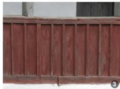
Parapetul poate fi zidit și văruiț cu alb (la modelele cele mai vechi) sau poate fi din scânduri de lemn simple sau traforate.
