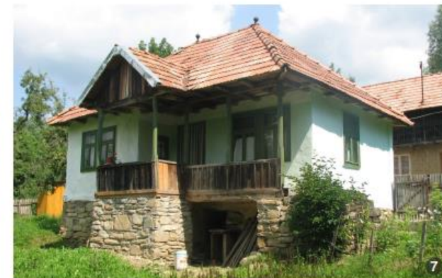
Casă cu pereți din lemn cu umplutură din pământ, așezați pe un bec construit din bolovani.
