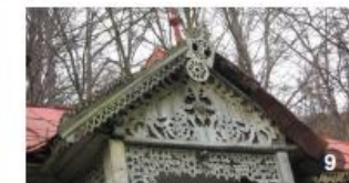
Foișorul poate avea trei sau două pante, poate avea fronton decorat sau nu cu traforuri abundente..
