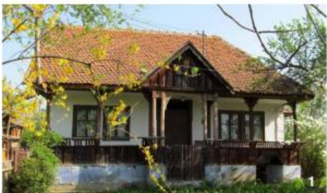
Acoperiș în patru ape, cu țiglă tip solzi.
