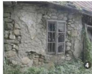
Zidărie din piatră.
