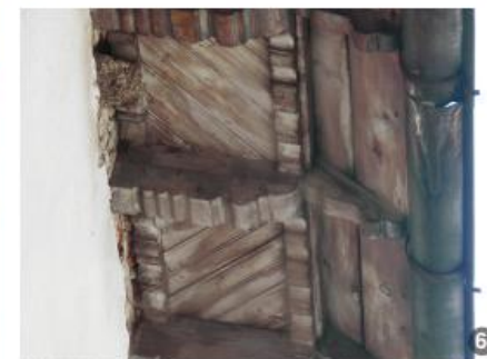
Modelele de case tradiționale cele mai vechi au streășină cu căpriori aparenti. La exemplarele începând cu stârșitul secolului al XIX-lea streășina poate fi înfundată.
