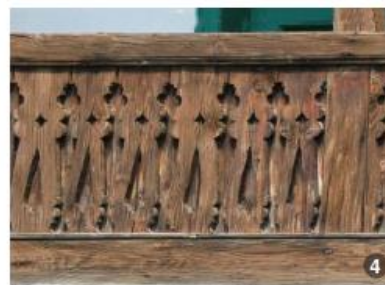
Parapetul poate fi zidit și văruiț cu alb (la modelele cele mai vechi) sau poate fi din scânduri de lemn simple sau traforate.
