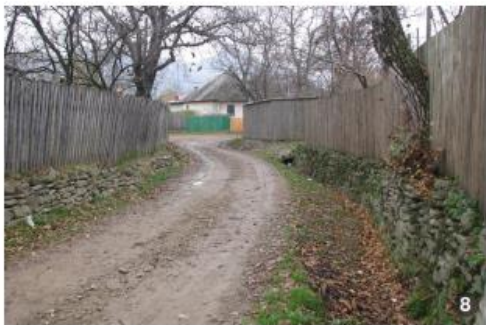
Zid de sprijin cu împrejmuire din lemn.
