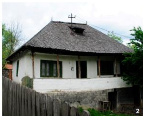
Construcții cu acoperiș cu patru ape, cu învelitoare din șindriță.
